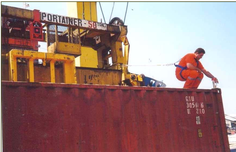
Fig. 4. Lavoro in sicurezza sopra container
