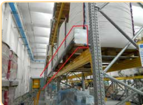
Scaffalature – elementi contro la caduta materiali
