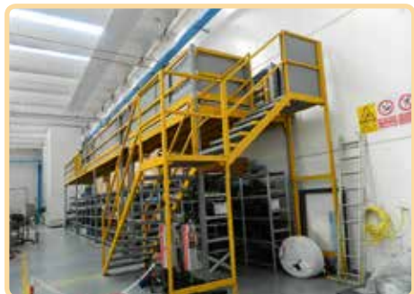
Soppalco con parapetto
