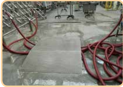
Copertura delle tubazioni enologiche con protezione calpestabile
