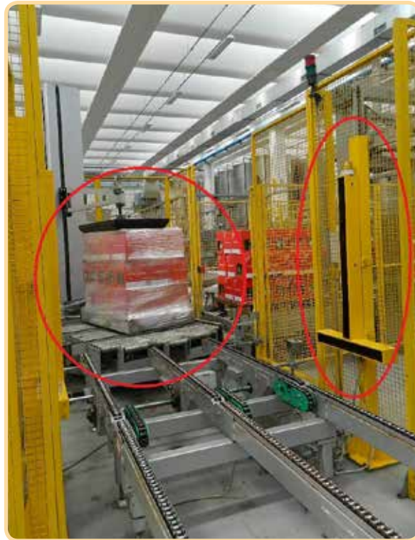
Pallettizzatore con fasciatrice e barriere immateriali
