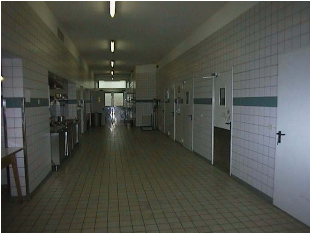
Ancora una vista degli ambienti comuni di una cucina di grandi dimensioni. Sulla destra si notano porte tagliafuoco dotate di dispositivo di autochiusura.
