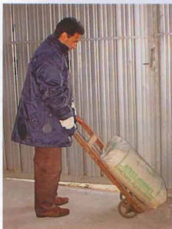
Carico manuale del materiale
