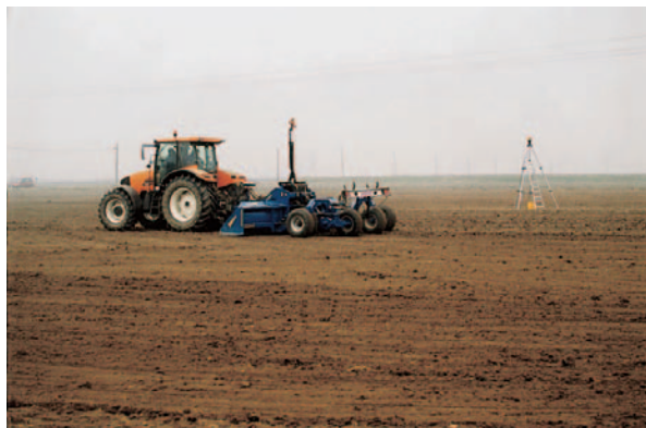
Livellatrice a controllo laser
