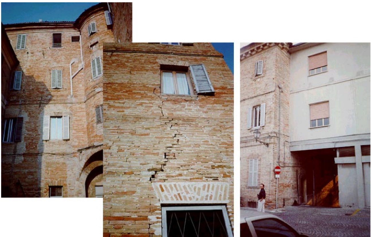
Figura 9: Edifici ospedalieri storici danneggiati dal terremoto di Umbria-Marche del 1997
