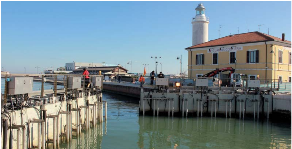
Le Porte Vinciane di Cesenatico (FC), un esempio di opera strutturale di mitigazione.
