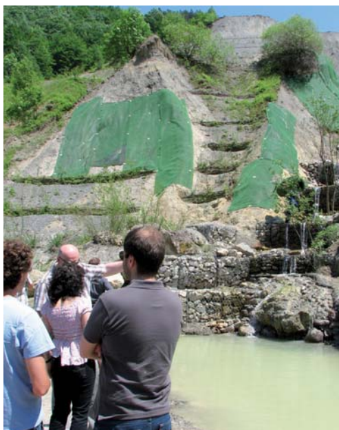
Terrazzamenti creati per prevenire le frane nel Parco Naturale Bulgarka in Bulgaria.
