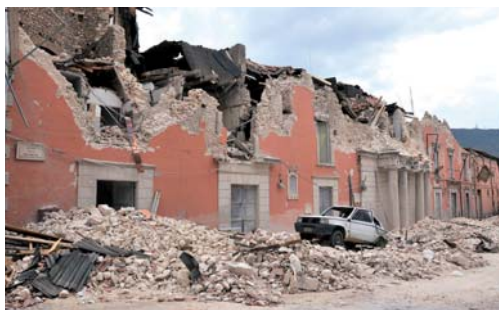
L'Aquila: edifici distrutti dopo il terremoto del 2009.
