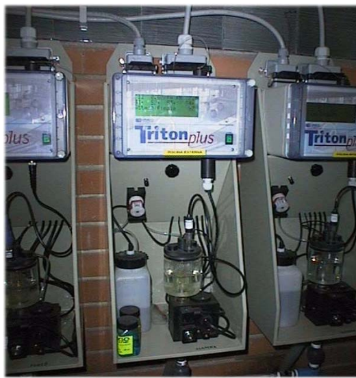
Esempio di centraline di dosaggio automatico dei preparati chimici necessari per l'igienizzazione delle acque delle piscine, normalmente ipoclorito di sodio e acido cloridrico in soluzione. Tutte questi dispositivi essendo di recente costruzione sono marcati CE
