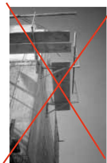
Fig. 3: le tavole posate a sbalzo sono particolarmente pericolose perché è impossibile individuarle dall'alto.
