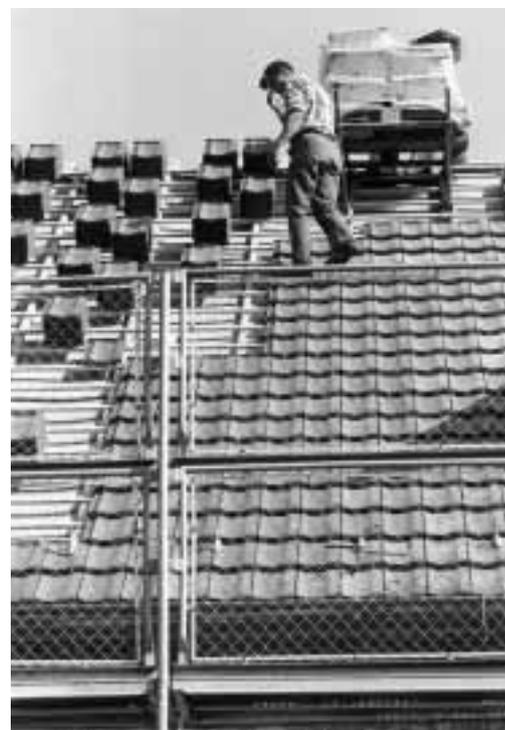
Fig. 6: sui tetti inclinati la parete di protezione in traliccio metallico per copritetti offre una protezione ideale contro la caduta di persone, oggetti e materiale.
