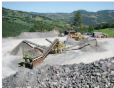
Foto 34 – Frantoio mobile e cumuli di materiale selezionato
