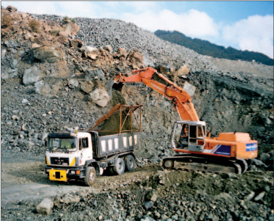
Foto 29 – Fase di carico (C. Pedroni)
