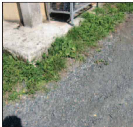
Foto 10 – Esempio di sottofondo stradale (S. Maria del Taro, PR)
