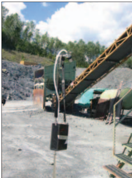
Foto 65 – Sistema per il prelievo dell'aria
