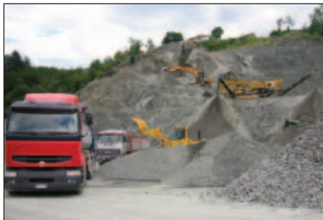
Foto 30 – Cava in attività: escavazione, frantumazione e caricamento
