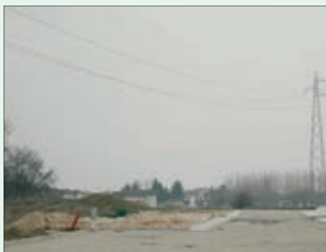
Situazione pericolosa per presenza di linee elettriche aeree in tensione non protette
