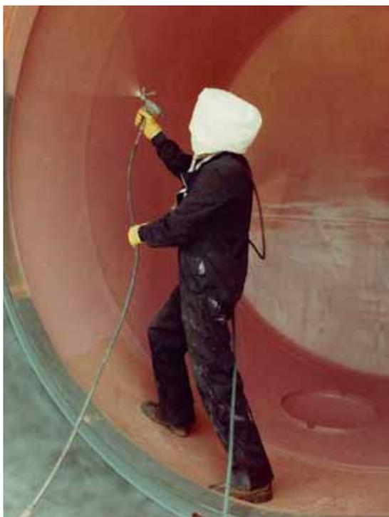
Fig. 6: le resine epossidiche sono una causa frequente di allergie cutanee. In caso di applicazione su una vasta superficie e soprattutto nei lavori di verniciatura a spruzzo, queste resine rilasciano vapori e aerosol che possono contaminare l'aria ambiente e scatenare un eczema. Per questo motivo è necessaria una protezione totale.
