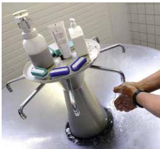
Fig. 17: stazione di lavaggio in un'azienda del settore metallurgico con diversi detergenti in funzione del tipo di sporcizia.
